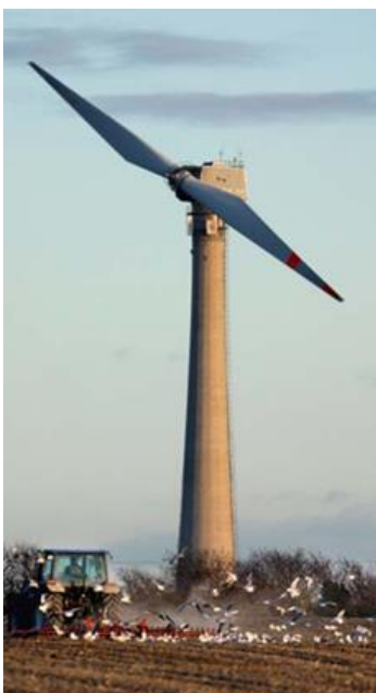
Näsudden II på Gotland Diameter 80 m, 3 MW
