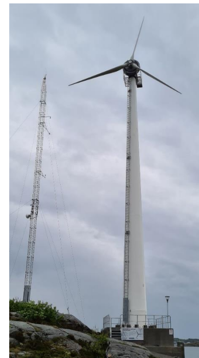
Chalmers forskningsturbin på Björkö med trätorn
